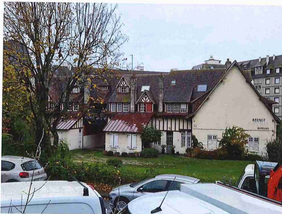
Photo 2 – façade arrière de la résidence
