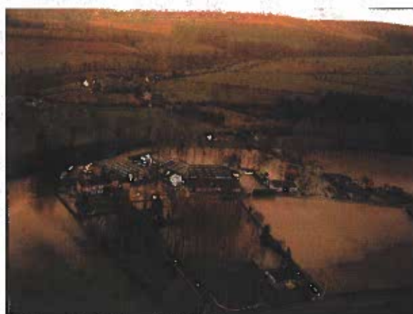
Figure n° 22 Usine à Cahan Source : DDE Calvados
